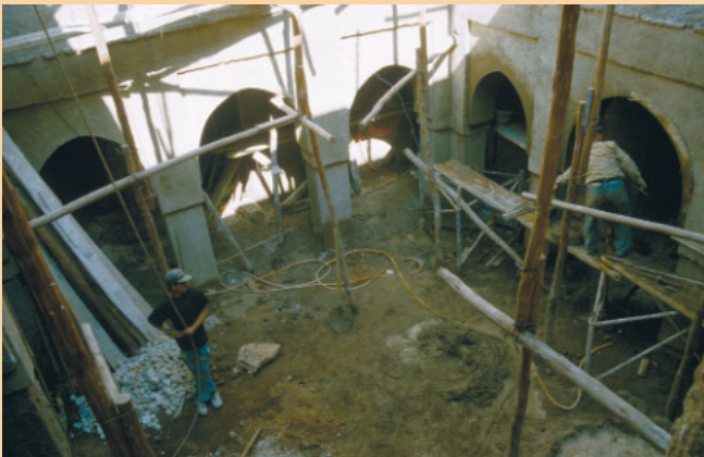
Foto 4, unten Sanierungsarbeiten in der Medina von Marrakesch
